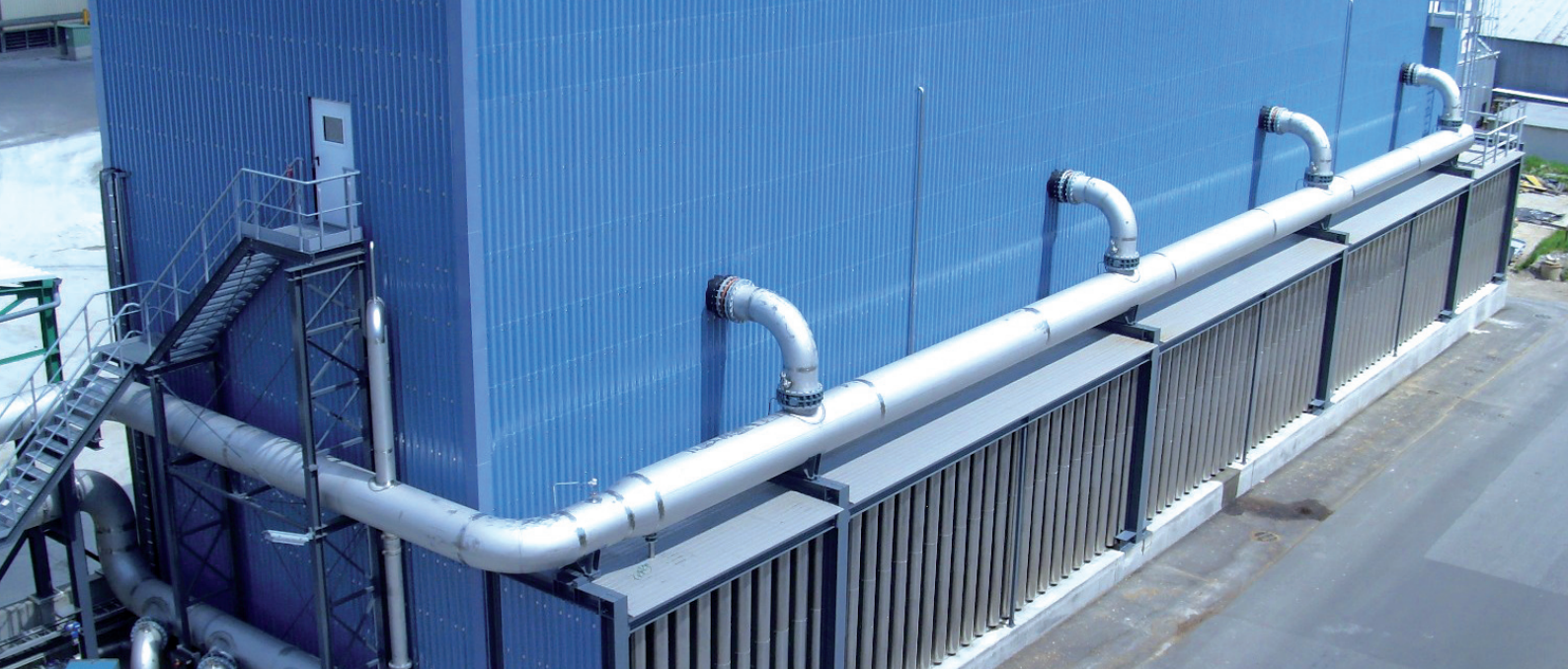
Иллюстрация 6: Секционная градирня типа EWZ119.
