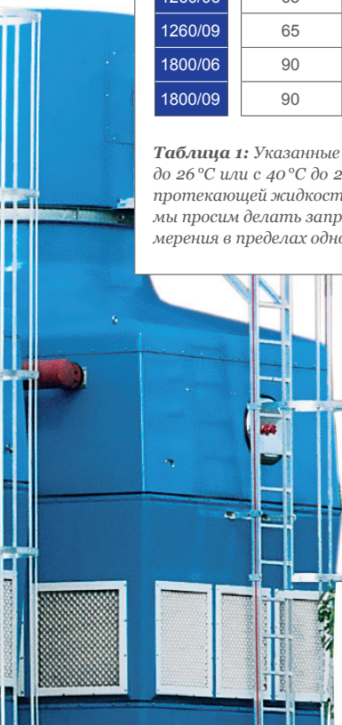
Иллюстрация 2: Две градирни с вытяжной вентиляцией типа EWK 1260 обеспечивают технологическое охлаждение у поставщика предприятий автомобильной промышленности.
